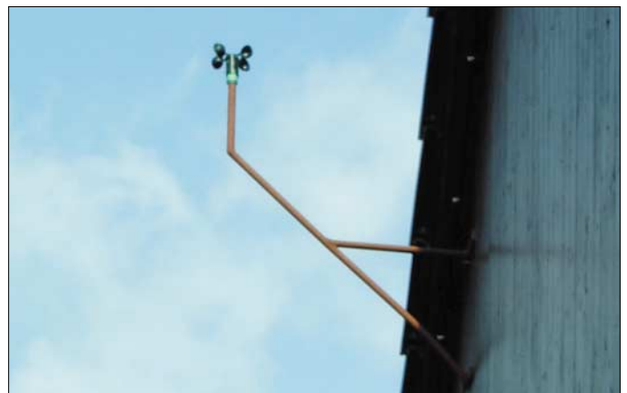
Bild 15: Anbringung des Windstärkesensors im Außenbereich an einem Ausleger
