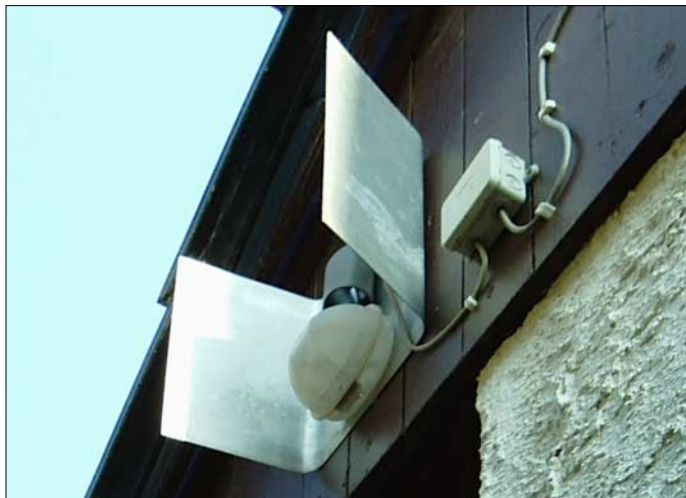
Bild 15: Anbringung des Windstärkesensors im Außenbereich an einem Ausleger
